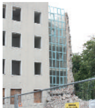
Abriß der ehemaligen Postwohnungen in der Alfonsstraße
