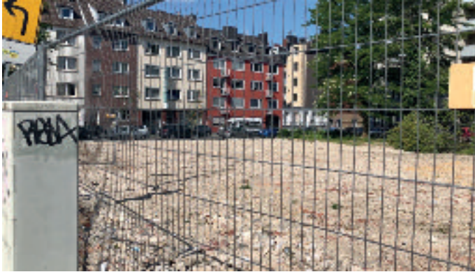
In der Alfonsstraße wurde bezahlbarer Wohnraum abgerissen, nun entstehen Eigentumswohnungen
